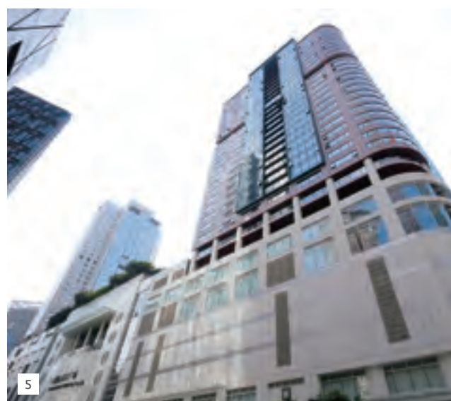
3 4 北京東方廣場 東方經貿城 5 重慶大都會 東方廣場商廈
